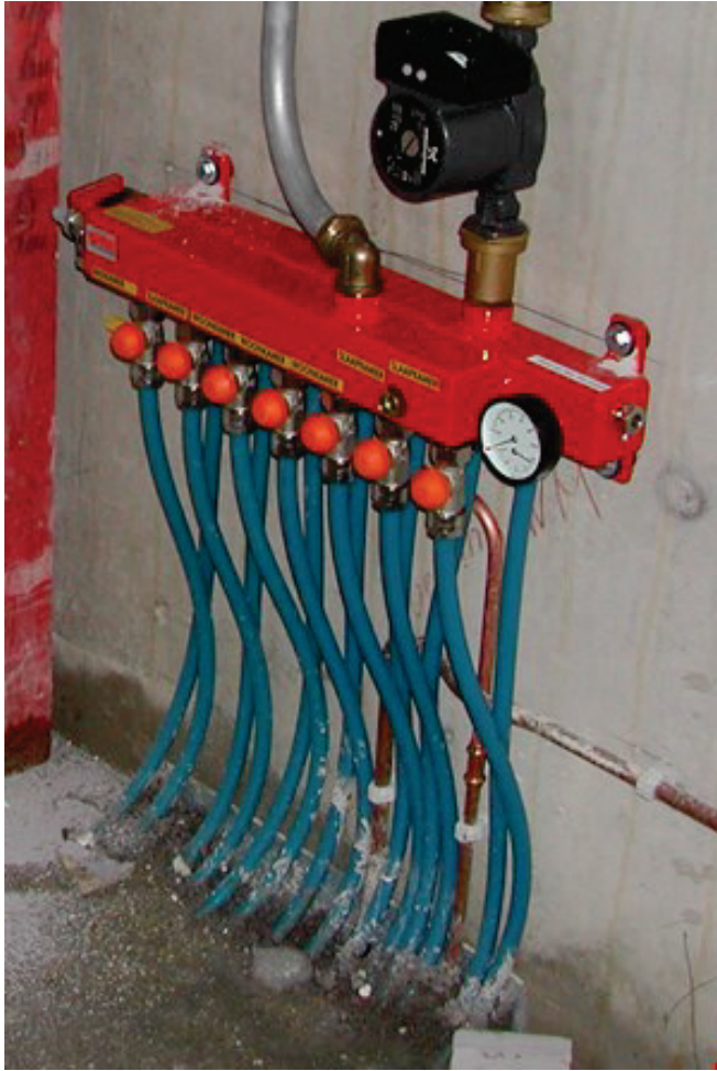
Afb. 7.12 Een verdeler met inregelvoorzieningen en afsluiters. De verdeler is nog niet voorzien van warmte-isolatie, maar dit is zeker aan te bevelen
