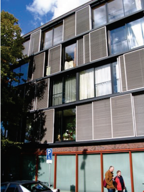
Afb. 4.10 Jaloezielijken of schuifschermen: één van de vele mogelijkheden voor zonwering. De lamellen kunnen zowel vast als draaibaar zijn, afhankelijk van het lameltype en fabricaat. Op de foto het project Delfts Blauw in Delft met luiken opgebouwd uit een frame en lamellen van aluminium; (Betrokken partijen: Limelight; architectenbureau: Architecten Cie en ontwikkelaar Eurowoningen)
