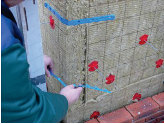
Afb. 5.21 Kunststof strip (of hoekanker) om zachte isolatieplaten bij uitwendige hoeken zorgvuldig op elkaar te laten aansluiten. (Bron: Gebroeders Bodegraven BV)
