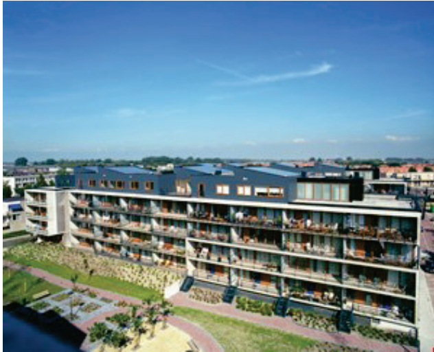
Afb. 9.22 Een collectief zonneboilersysteem op appartementencomplex Charivarius te Haarlem. Een project van Eco Energy en Pré Wonen Haarlem; (Betrokken partijen: aannemer: Panagro; architect: HMADP groep; adviseur: BOOM-S/I; Realisatie 2005; Eneco)
