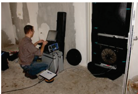
Afb. 5.2 Luchtdichtheidsmeting met behulp van een tijdelijk aangebrachte 'blowerdoor'. Met behulp van rookdetectie kunnen luchtlekken zichtbaar worden gemaakt. (Bron: Nieman Raadgevende Ingenieurs)
