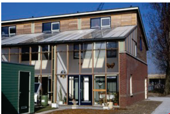
Afb. 4.16 Serres bij huurwoningen in Banne-Oost in Amsterdam-Noord. Het dak van de serre is deels voorzien van (doorzichtige) beglazing in verband met daglichttoetreding. Op het dak zijn ook zonnecollectoren aangebracht. (Betrokken partijen: ontwerp: Tjerk Reijenga, voorheen BEAR Architecten, Gouda. Realisatie: 1995)
