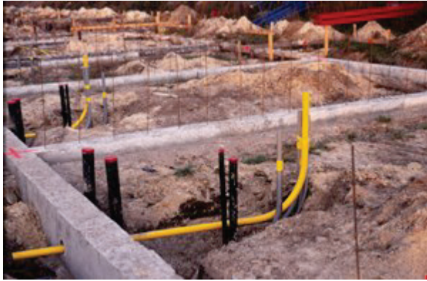
Afb. 5.10 Op tal van nieuwbouwlocaties wordt zonder kruipruimte gebouwd. Op de foto een voorbeeld van bouwen zonder kruipruimte op de Vinex-locatie Nieuwland in Amersfoort
