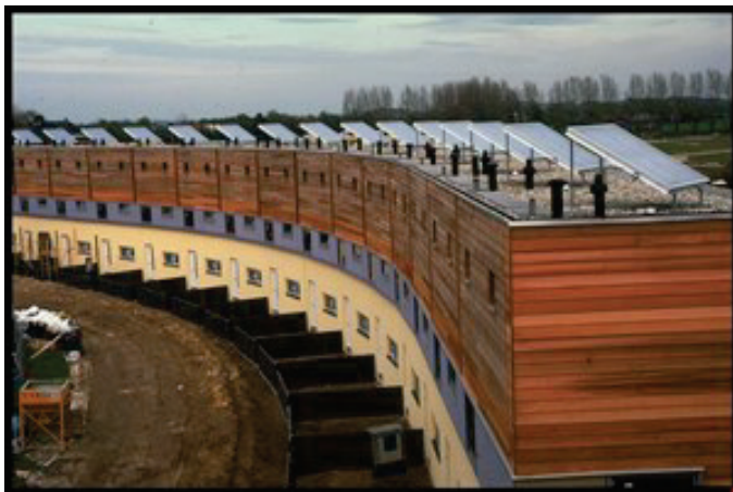
Afb. 4.2 Woningen met zonnecollectoren op platte daken in Nieuwland, Amersfoort. Alle collectoren zijn op het zuiden gericht ondanks de wisselende oriëntatie van de woningen. (Bron: ontwerp: Olga Architecten)
